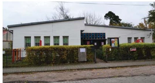
Obecny budynek Wypożyczalni nr 32 przy ul. Błękitnej
