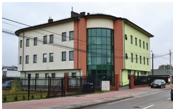
Budynek szkoły przy ul. Bronowskiej
